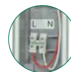
Bornera de conexión
