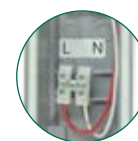
Bornera de conexión
